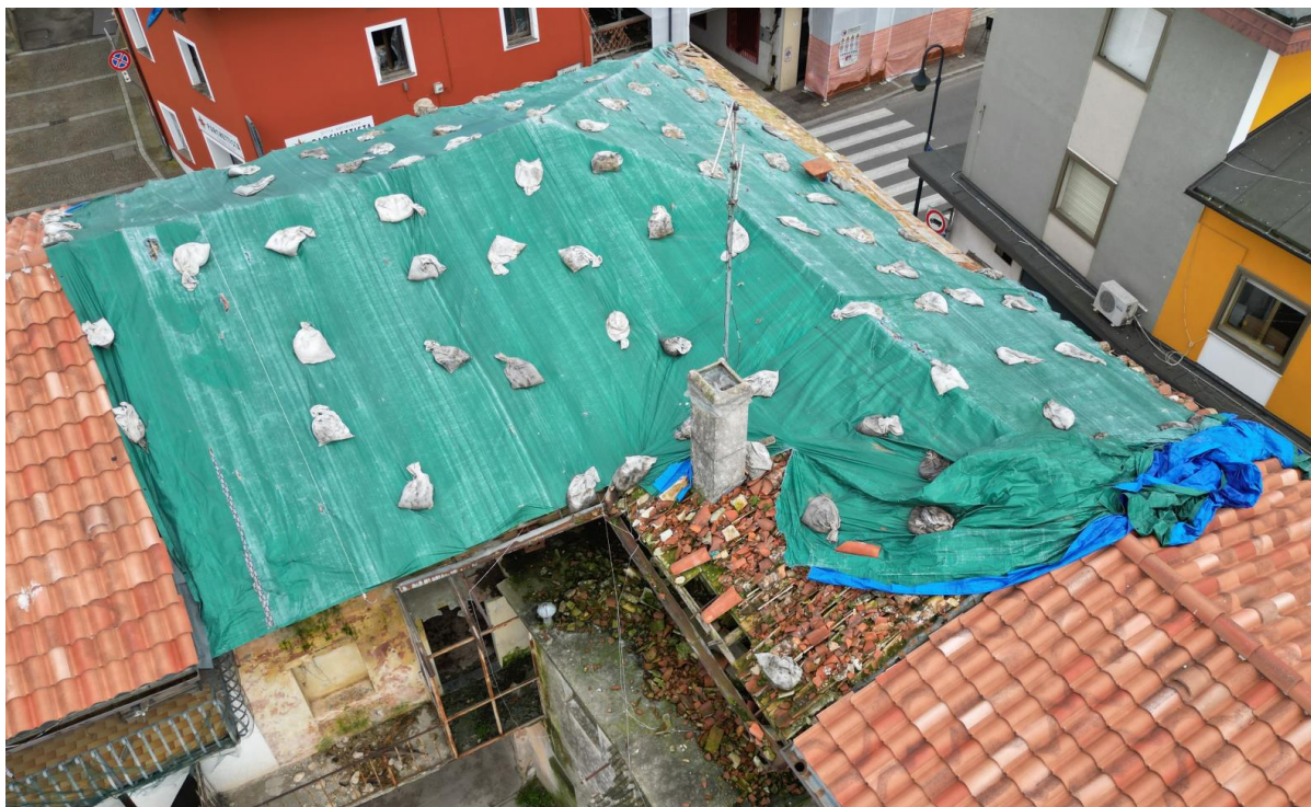
Figura 6 - foto con drone, evidenza esterna di cedimento della copertura e precarietà generale
