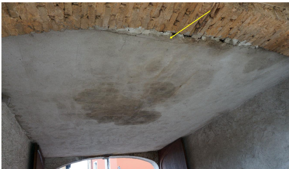
Figura 14 solaio androne con distacco intonaci
