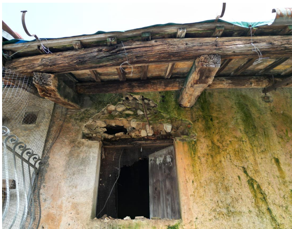
Figura 9 - facciata verso cortile interno, cedimento appoggio capriata
