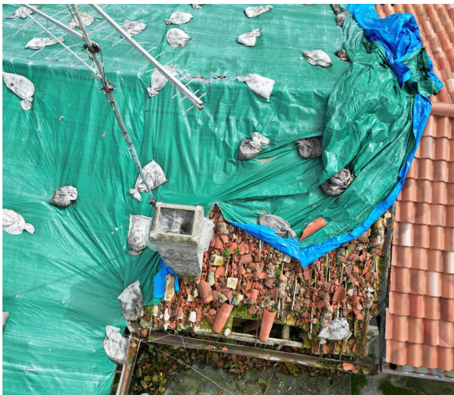
Figura 7 copertura di emergenza in teli presente da luglio 2023 in rovina ed elementi pericolanti di copertura
