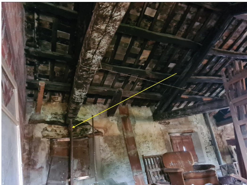
Figura 12 sommaria puntellazione esistente di appoggio capriata lato via Cavour
