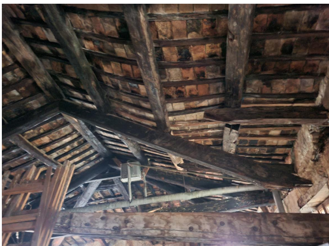
Figura 13 cedimento orditura secondaria e copertura in corrispondenza al cedimento della seconda capriata
