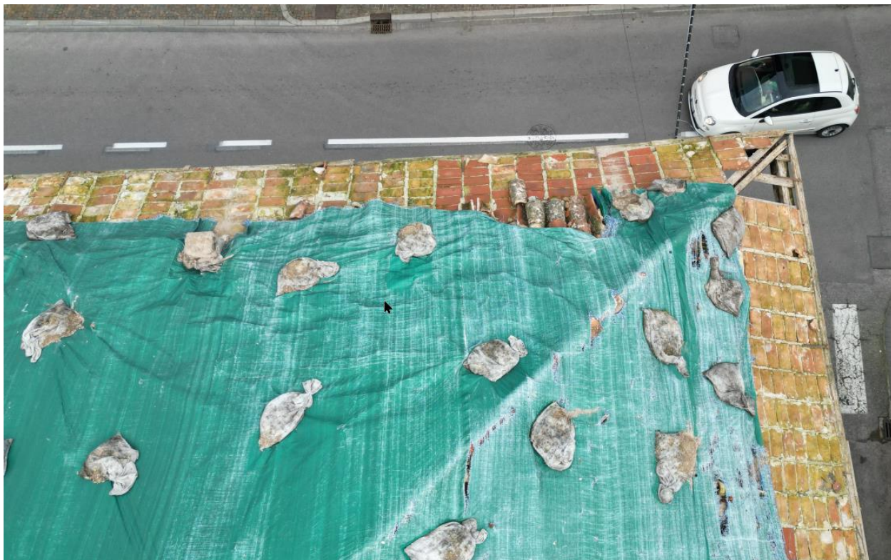
Figura 8 elementi di copertura a rischio caduta e rovina al suolo
