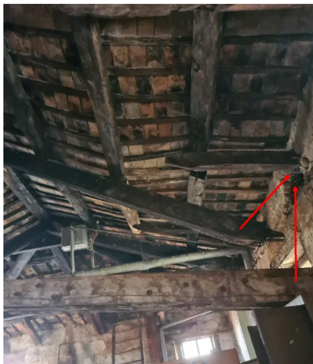
Figura 11 - immagine da interno, cedimento appoggio seconda capriata e spanciamiento orditura secondaria
