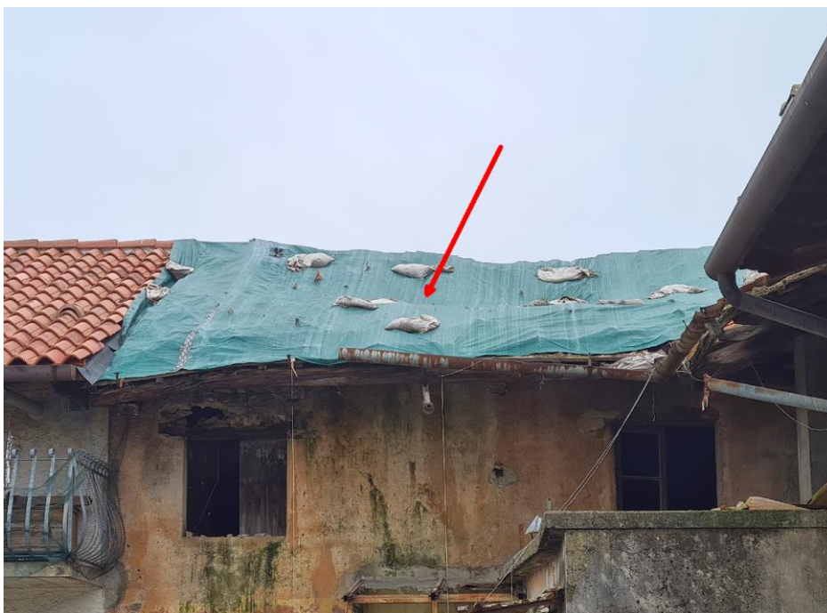
Figura 10 - ulteriore cedimento della copertura in corrispondenza alla seconda capriata
